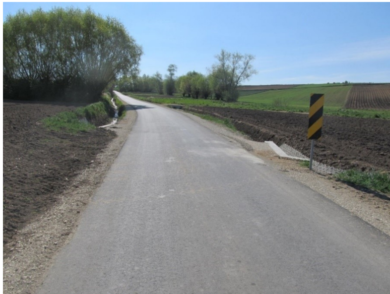
Zdjęcie 15. Droga gminna Małoszów-Gunów w miejscowości Małoszów po remoncie.
