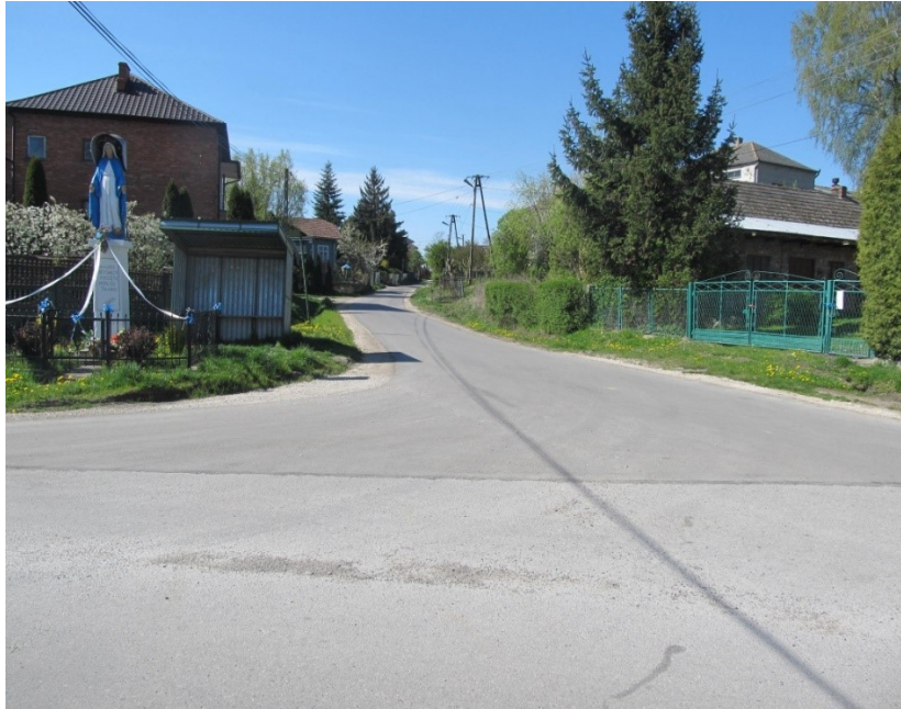
Zdjęcie 13. Droga gminna nr 003512T Podgaje-Drożejowice w miejscowości Drożejowice po remoncie.
