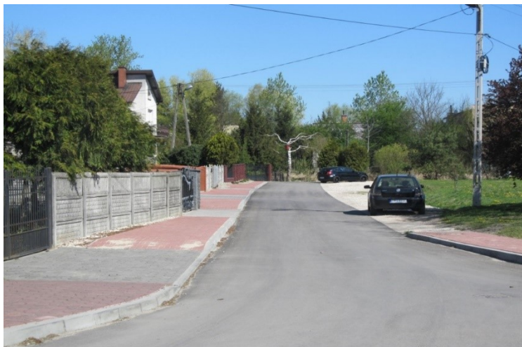
Zdjęcie 11. Skalbmierz, ul. Rep. Partyzanckiej po przebudowie.
