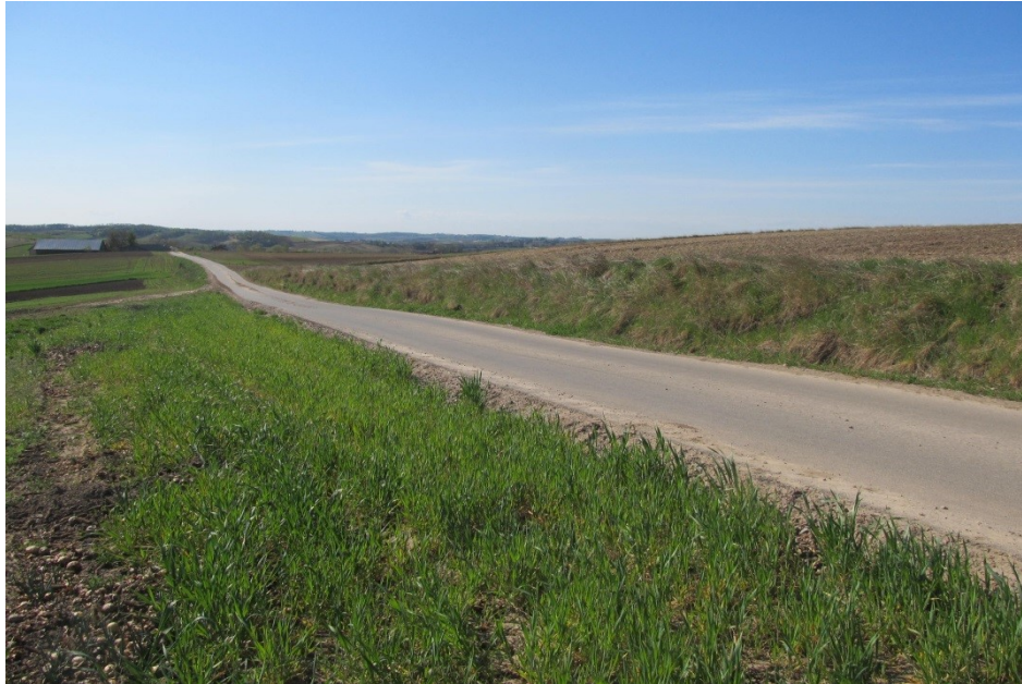
Zdjęcie 10. Droga w Szczekarzowie po przebudowie.
