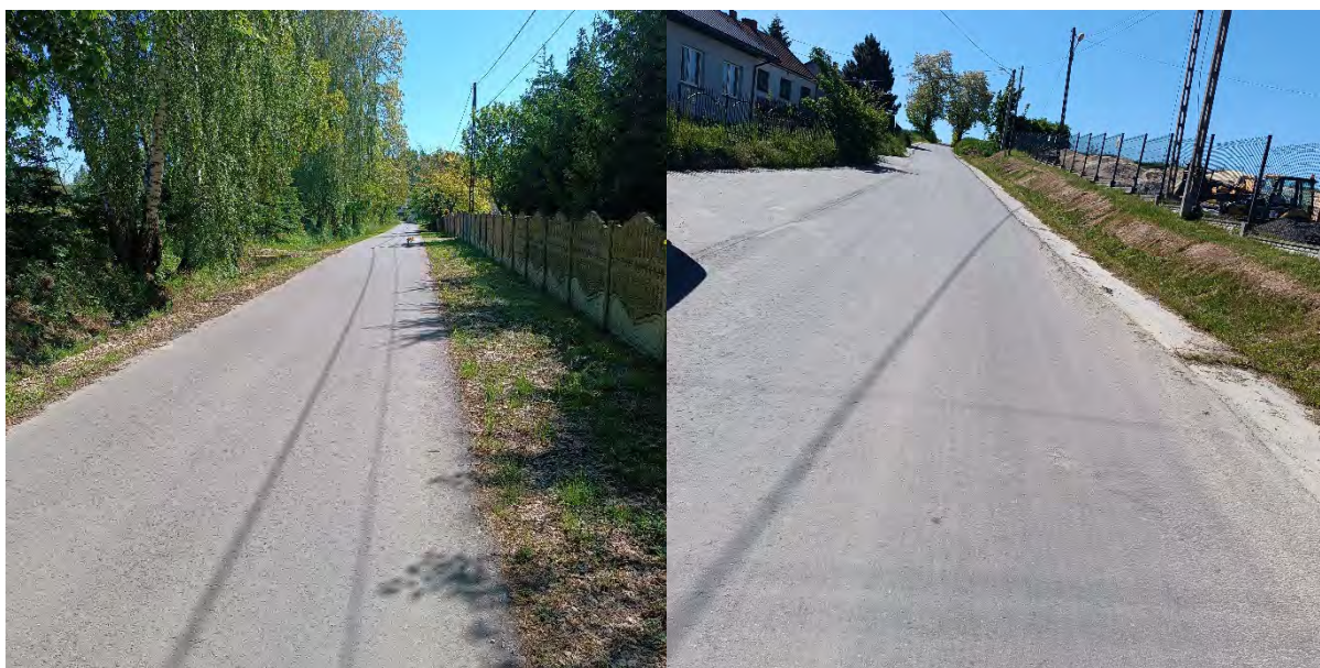
Zdjęcie 2. Droga gminna w miejscowości Tempoczków Rędziny po remoncie.
