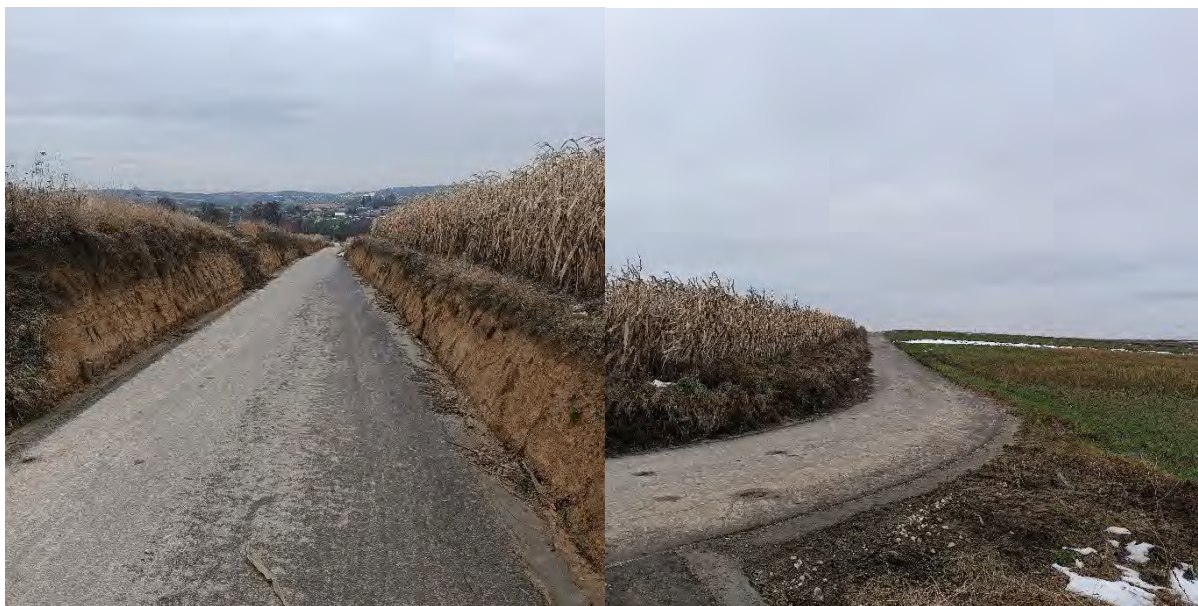
Zdjęcie 3. Droga wewnętrzna w miejscowości Rosiejów po przebudowie.
