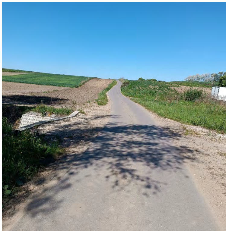
Zdjęcie 6. Droga wewnętrzna w miejscowości Topola po przebudowie.
