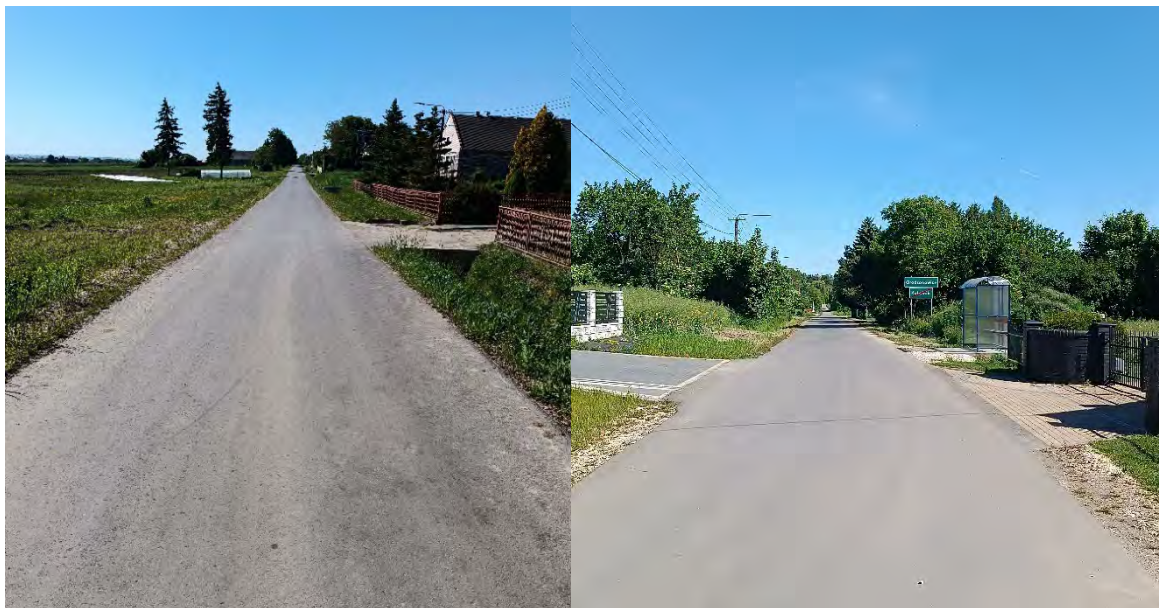
Zdjęcie 1. Droga gminna w miejscowości Grodzonowice po remoncie.
