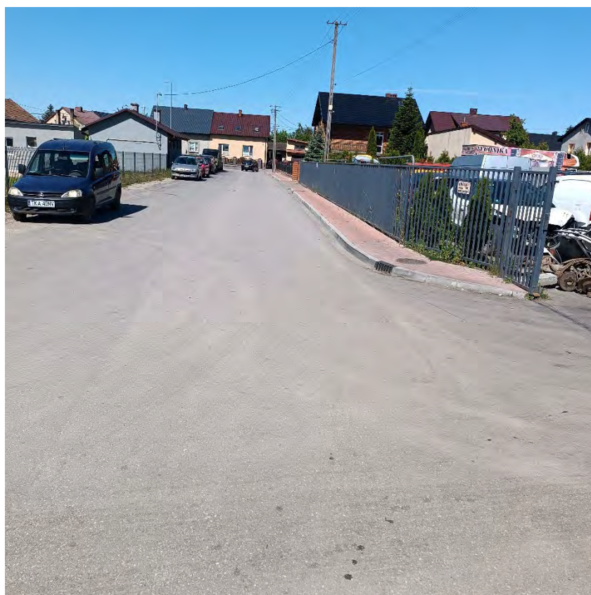
Zdjęcie 7. Droga wewnętrzna w Skalbmierzu po przebudowie.
