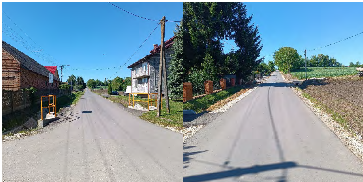
Zdjęcie 4. Droga gminna w miejscowości Topola po remoncie.
