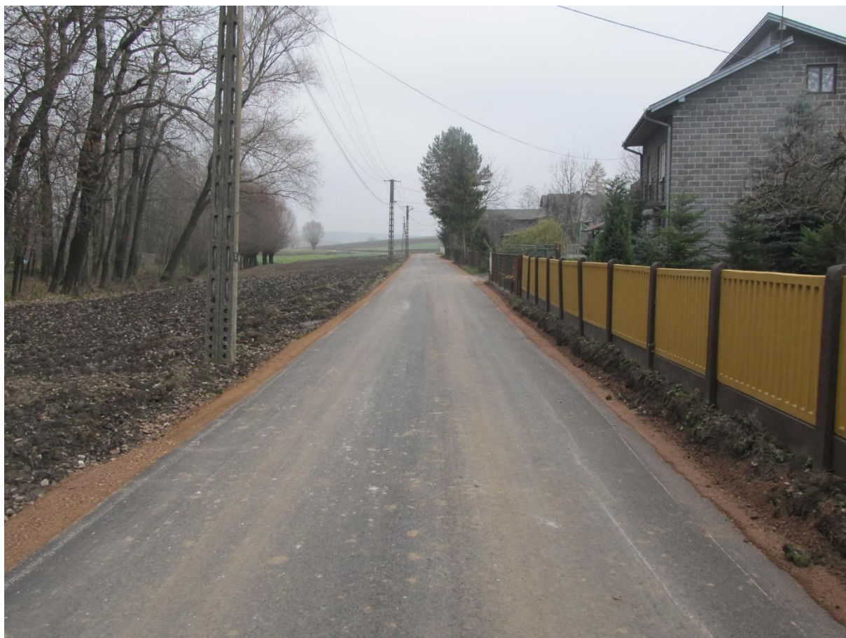
Zdjęcie 4. Baranów, droga po przebudowie (modernizacji).
