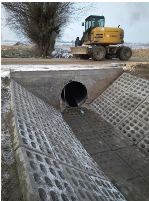
Przebudowany przepust wraz z umocnieniem skarp pod drogą Kobylniki-Ostrów.
