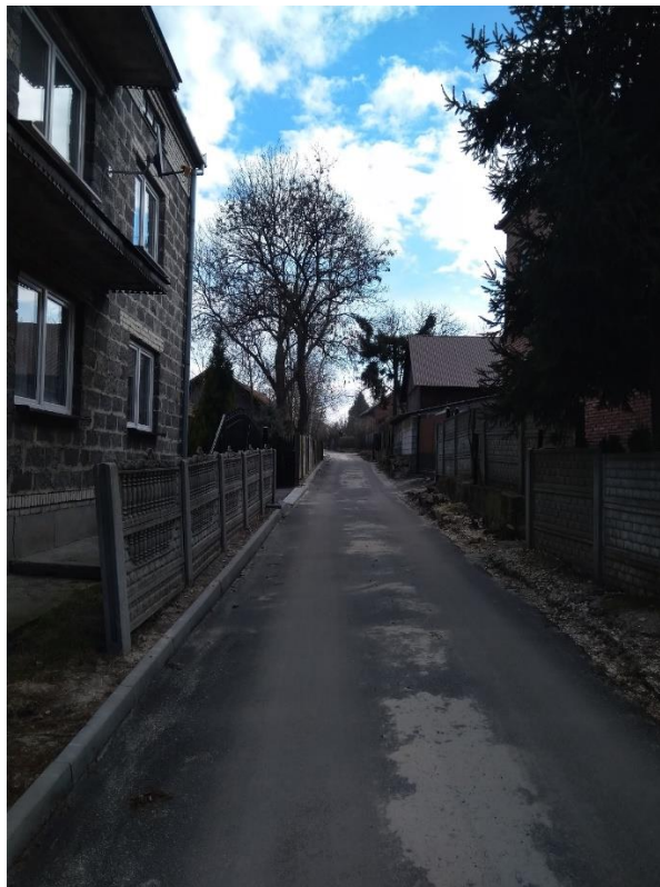
Skalbmierz, ul. Mickiewicza po przebudowie.
