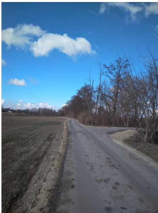
Topola, droga po przebudowie (modernizacji).
