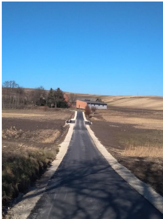
Wyremontowana droga Nr 378014T Przybenice-Małoszów wraz z przebudowanym potrójnym przepustem okularowym.
