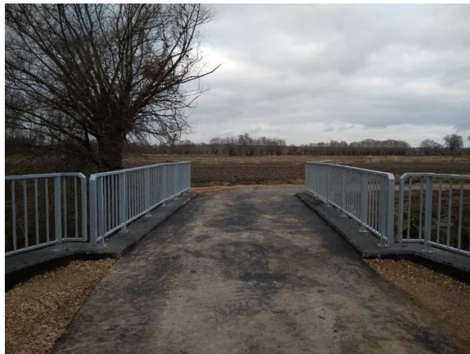
Topola most. Stan po przebudowie.
