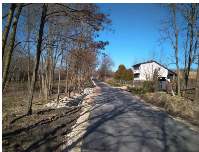
Droga gminna nr 378018T Boszczynek-Belzów po remoncie.
